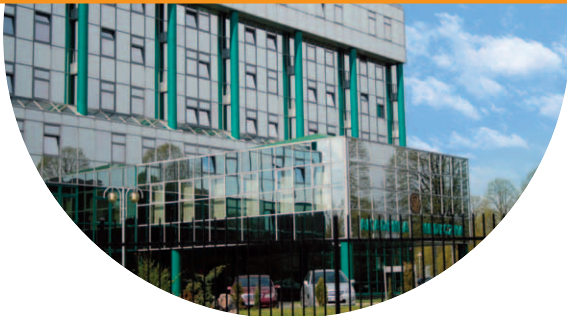
Het gebouw van de Medische Academie in Warschau (Polen): er zijn 30 DEFENDER XW geïnstalleerd.
