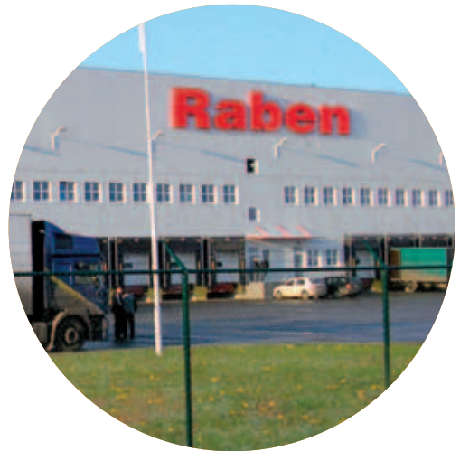
Het magazijn van de internationale transport-firma RABEN in Kiev (Oekraïne): in de opslagplaats zijn 114 VOLCANO VR2 geïnstalleerd.
