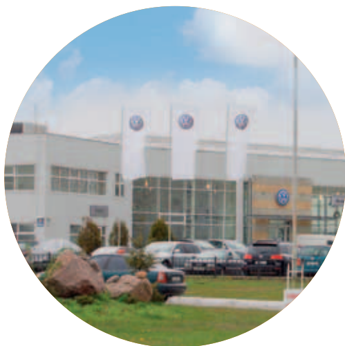
Volkswagen-autodealer in St. Petersburg (Rusland): er zijn 8 VOLCANO VR1 en bij de ingang 1 DEFENDER XE geïnstalleerd.
